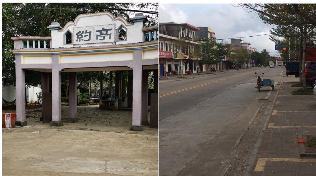
镇区排水现状
